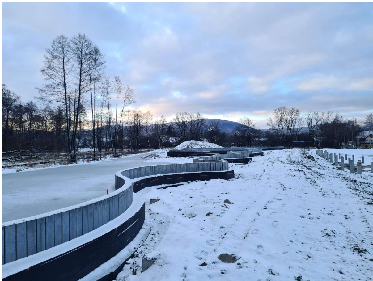
Fot. 2. Mur oporowy zlokalizowany po wschodniej części grobli Stawu Anteckiego, po prawej stronie widoczne wykonane pale pod dolny pomost
