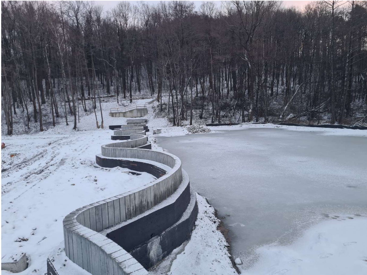
Fot. 1. Widok na wschodnią część inwestycji widoczny mur oporowy pomostu nad wodą, po lewej stronie muru widoczna grobla Stawu Anteckiego, po prawej stronie widoczny przygotowany teren pod budowę terenów rekreacyjnych
